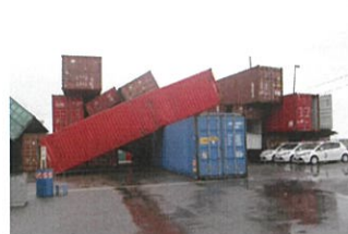
平成 30 年 9 月台風 21 号での 大阪港の被害状況
